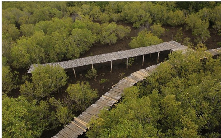
Gambar 4.2. Jembatan Bambu Wisata Hutan Mangrove Desa Reroroja. Potret: Rodrikues Bara
